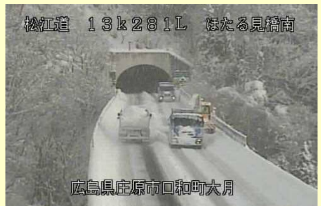
除雪作業 (広島県庄原市口和町)
