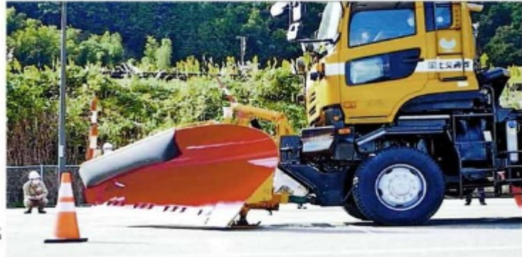
路面の構造物を避けて除雪板を上げ下げできるか確かめる実験 ＝昨年10月17日、庄原市 (広島工業大菅雄三研究室提供)
