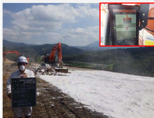
ICT活用による地盤改良工
