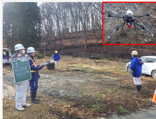
UAVレーザーによる起工測量
