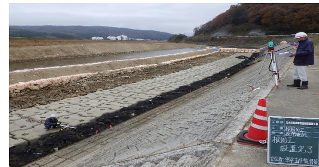
○当工事は河川内で大型土のうを利用した仮締切内にて根固めブロックを設置する工事であった。大型土のうによる仮締切では施工箇所への流入に対して水替えを行った場合も水が残留し、施工時は一部で水中作業を必要とする箇所があった。水中作業時は水面が濁り、仕上がり面の目視確認ができなく作業効率が落ちることが懸念されていた。そこでバックホウのモニターで許容値差を確認できるマシンガイダンスによる施工を行い、目視確認できない濁水中での作業効率を落とすことなく施工を完了することができた。
