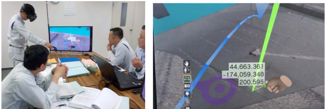
写真 4-5-1 試行における出来形確認状況
